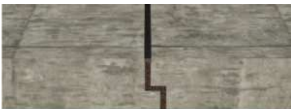
Junta de dilatação descontinua
